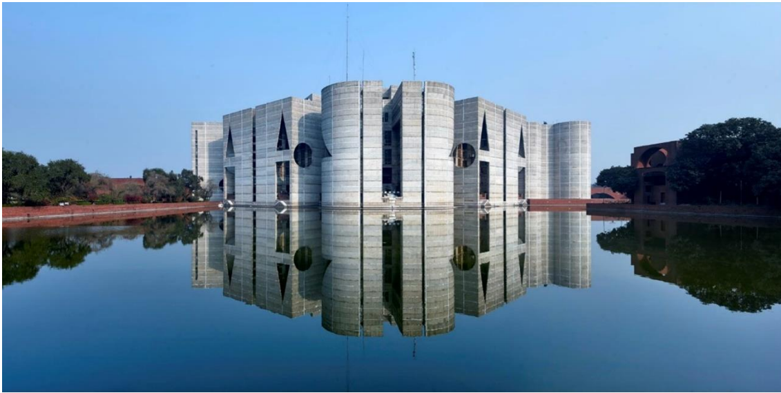
Şekil 4. Dhaka Meclis Binası genel görünüm (Kaynak: Url-2).
