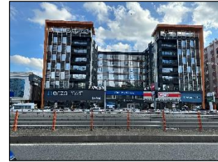
Buğdaycılar Office Plaza
