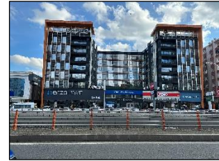
Buğdaycılar Office Plaza
