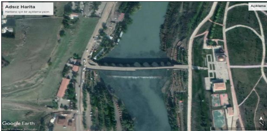
Şekil 8. Köprü'nün restorasyon sonucu genel görünümü (Google Earth)
