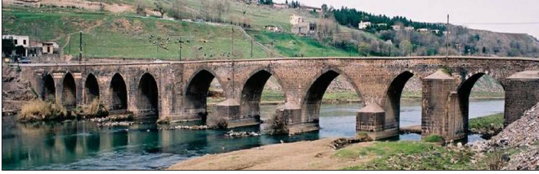
Şekil 4. Dicle Köprüsü restorasyon öncesi mansap yüzü ve yakın çevresi(Sert 2009:635)
