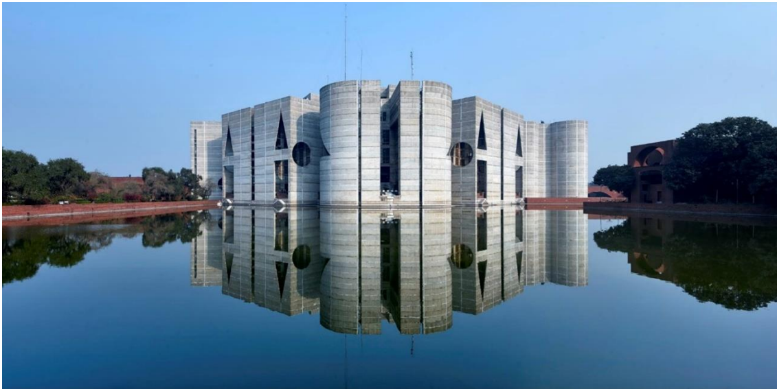
Şekil 4. Dhaka Meclis Binası genel görünüm (Kaynak: Url-2).
