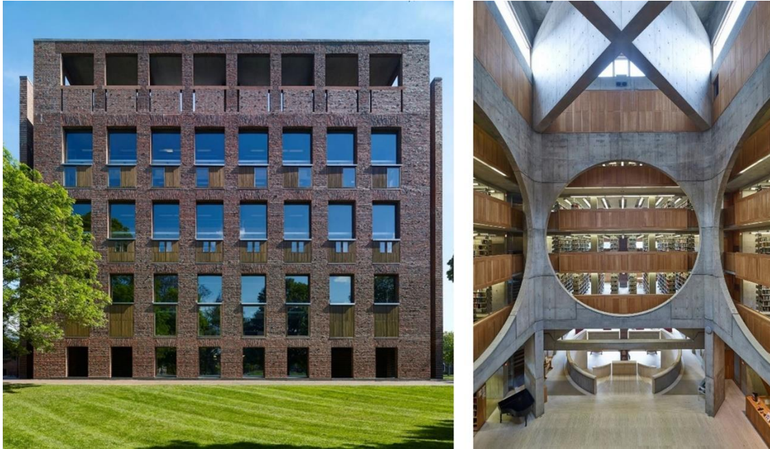
Şekil 9. Exeter College Kütüphanesi cephe fotoğrafı (solda), iç mekan fotoğrafı (sağda) (Kaynak: Url-2).
