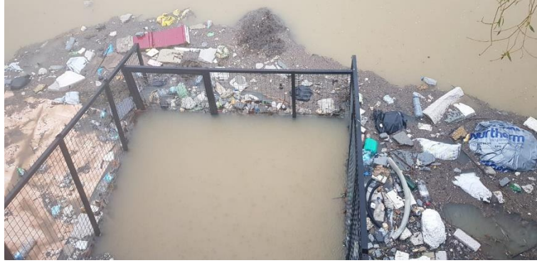
Şekil 30: Fotoğraf Hamursuz I Düdeni'nde mevcut menfez önünde yer alan ızgaraların düdenin tıkanmasını önleme noktasında ne denli önemli olduğunu göstermektedir.
